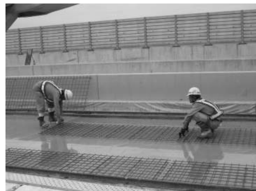
写真—2.2 CFRP グリッド筋の設置
