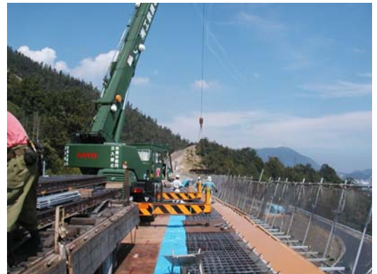
写真-2 橋面での鋼材パネルの敷設
