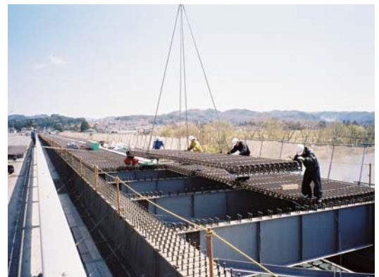
写真-1 橋梁外からの鋼材パネルの敷設
