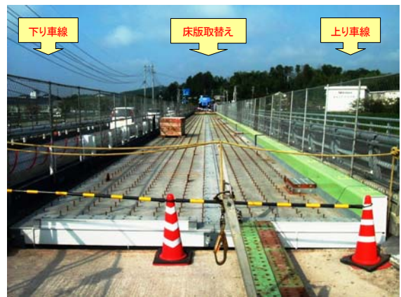
写真-5 分割施工
